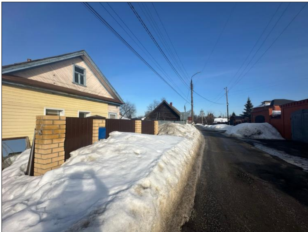
Илл. 20. Видовая фотофиксация трассы проектируемого объекта «Газопровод-ввод к жилому дому по адресу: 606502, Нижегородская обл., Городецкий р-н, Городец г., Ворожейкина ул., д. 10» (код объекта 152-22-102-041110). Вид с ЮЮВ на завершающий отрезок трассы проектируемого объекта
